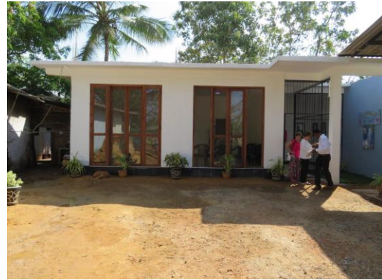
Gebouw bij opening in maart 2019
