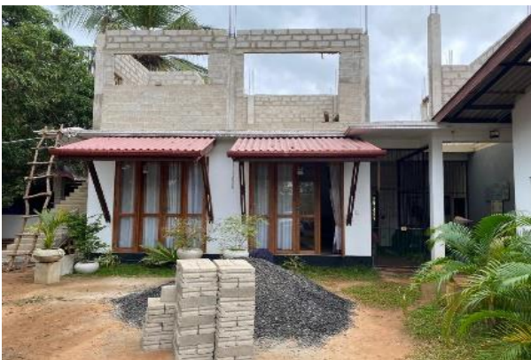
Zo begon de bouw van de verdieping
