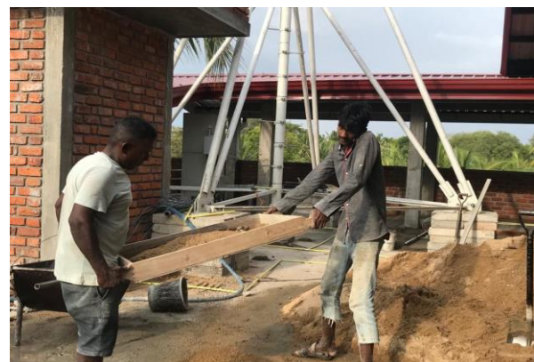
Bouwlieden aan het werk
