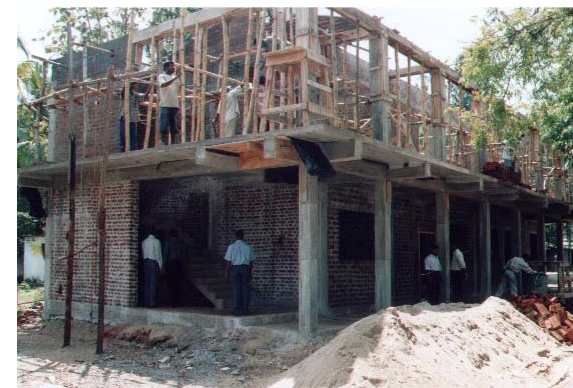
internaat op verdiepingshoogte
